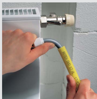
Ruční ohýbání trubky
